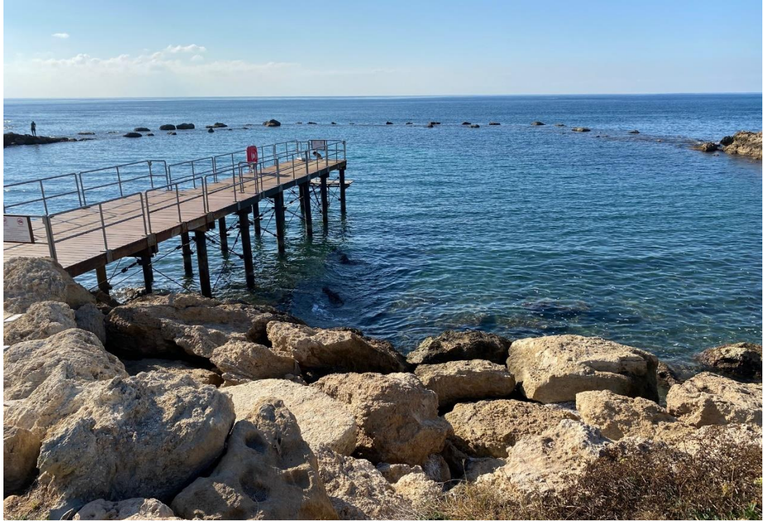
Φωτ.9 Βόρειο τμήμα κεντρικής ακτής (βραχώδες), προβλήτας πρόσβασης και κατεστραμμένο ύφαλο έργο
