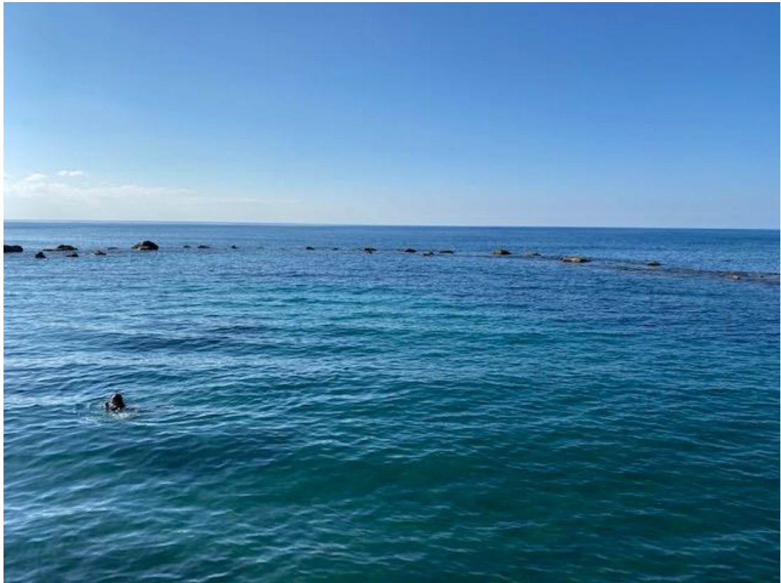
Φωτ.10 Κατεστραμμένο ύφαλο έργο
