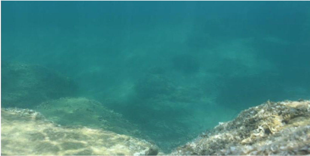
Φωτογραφία 7.7: Κλίση ύφαλου κατεστραμμένου κυματοθραύστη
